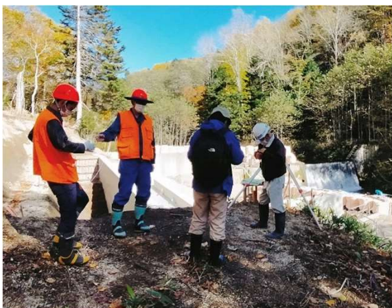
【魚道工事現場】
