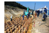
木柱を用いた土木工事
