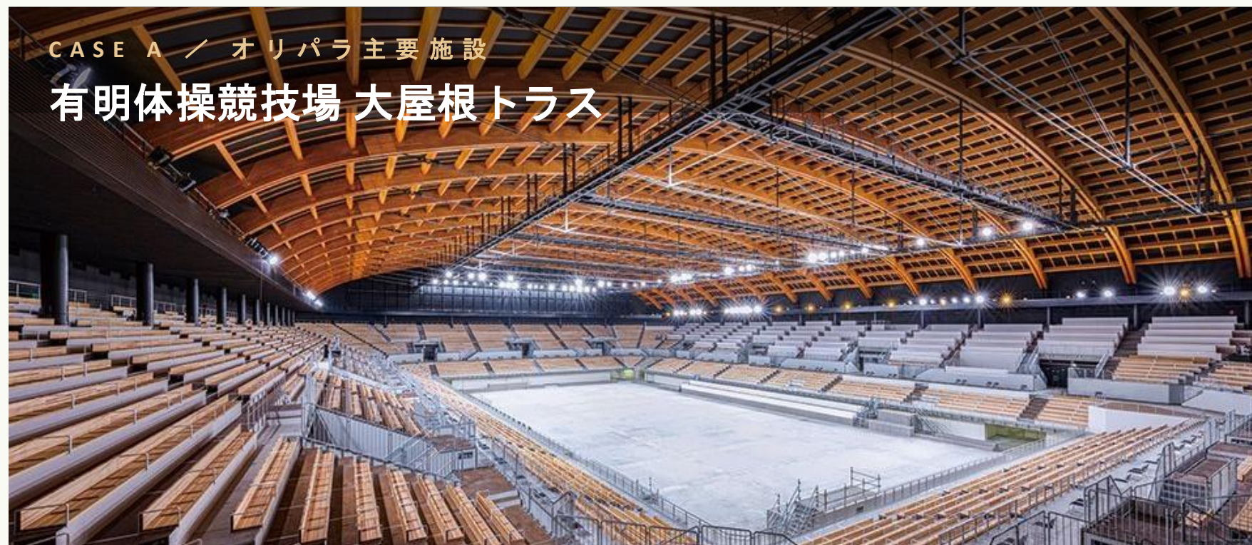
屋根構造材：長野県東信産カラマツ集成材
