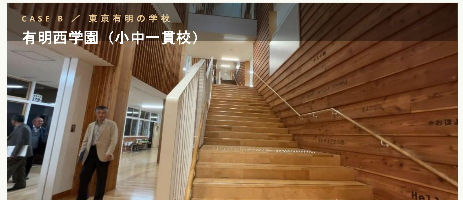
壁・階段・内装：長野県東信産カラマツ集成材
